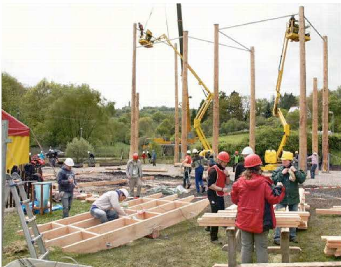
Die fleißigen Helfer legten kräftig Hand an bei der Erstellung des neuen Hochseilgartens.
